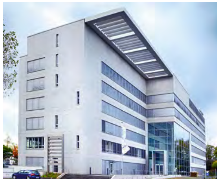
Eschborn (OB V): u.a. Firmenzentrale des Immobilienentwicklers Aurelis.
